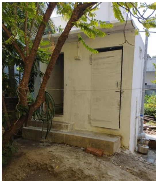
Construction d'une douche et de toilettes pour Devi, octobre 2022
